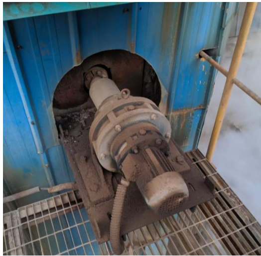
Gambar 2. 11 Motor Penggerak Rapper
