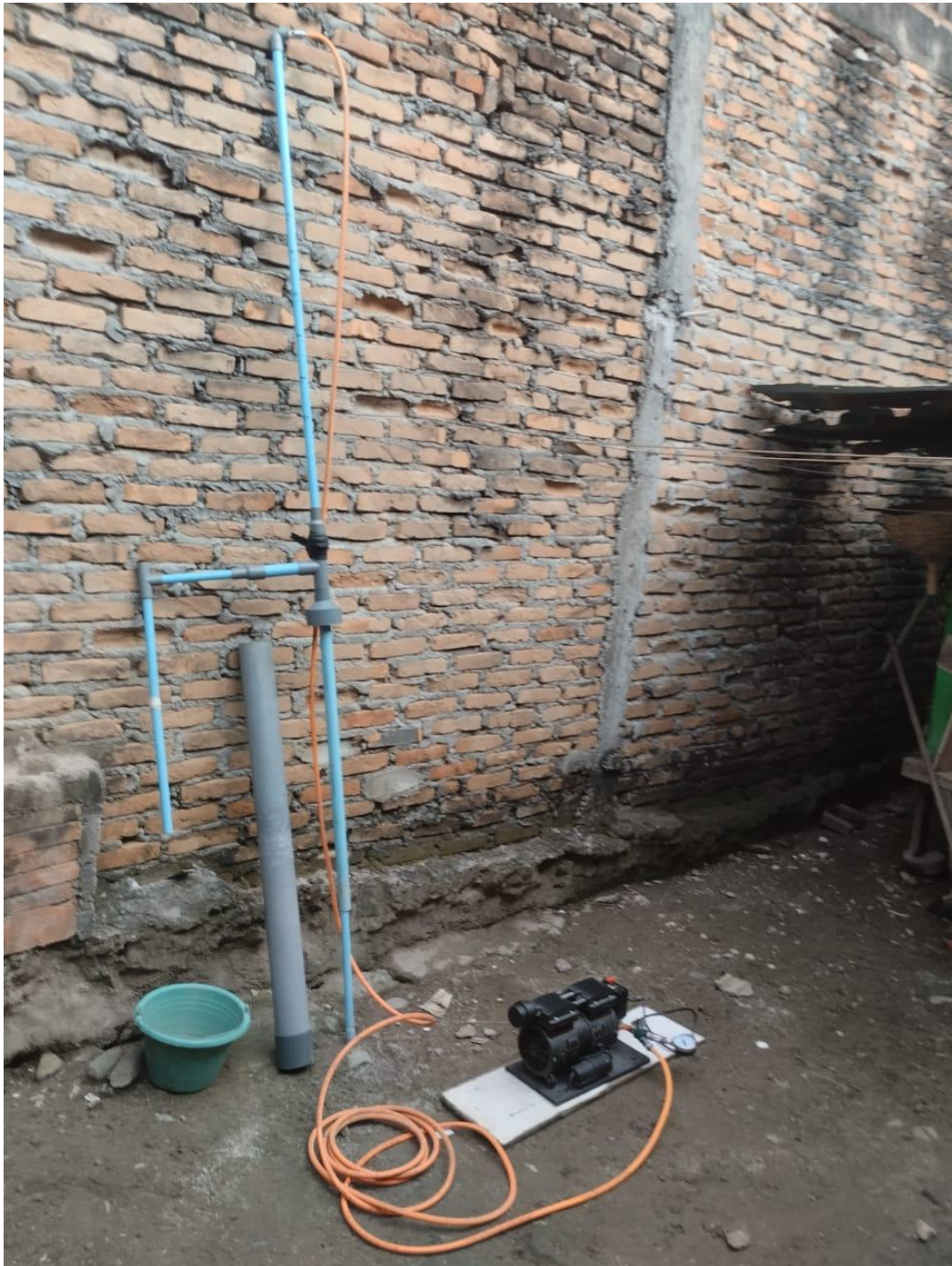
Gambar 1. Instalasi dan pengoperasian pada pipa sumur 1 meter
