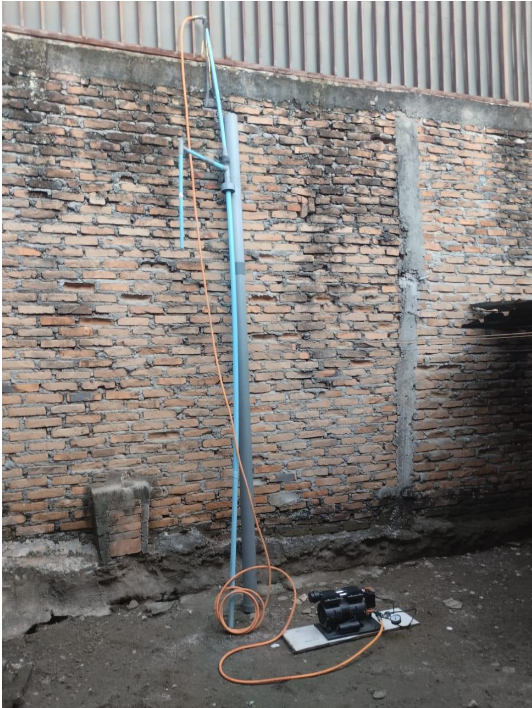
Gambar 3. Instalasi dan pengoperasian pipa sumur 3 meter
