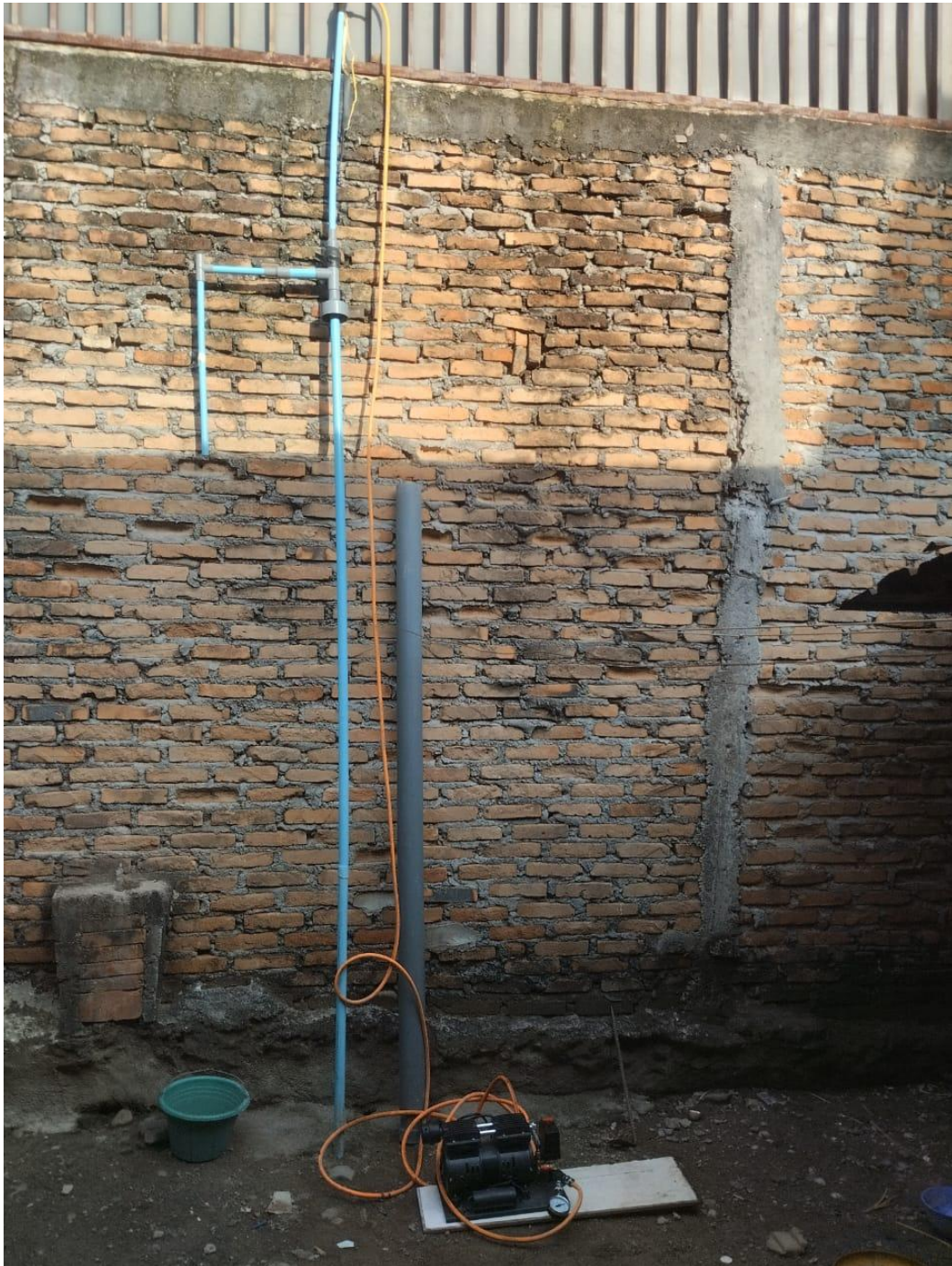
Gambar 2. Instalasi dan pengoperasian pada pipa sumur 2 meter
