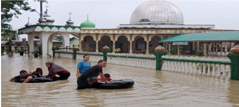
Kejadian pasca banjir di area Mesjid Jami' Kecamatan Sei Rampah dekat Dengan sungai Sumber : Google
