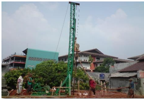
Gambar 2. 3 Pembuatan bored pile mini crane
