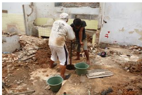
Gambar 2. 5 Pembuatan Bored Pile Manual
