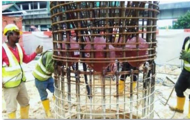
Gambar 2. 13 Instalasi Yjack pada pondasi bored pile
