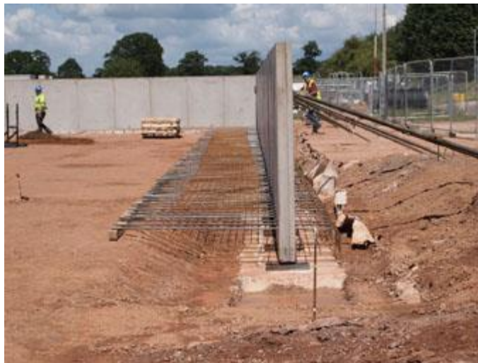
Gambar 2.6 Tembok Penahan Tanah Kantilever
