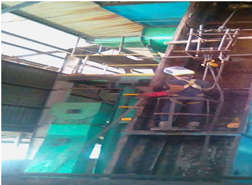
h. Pergantian pada liner (rail track)
