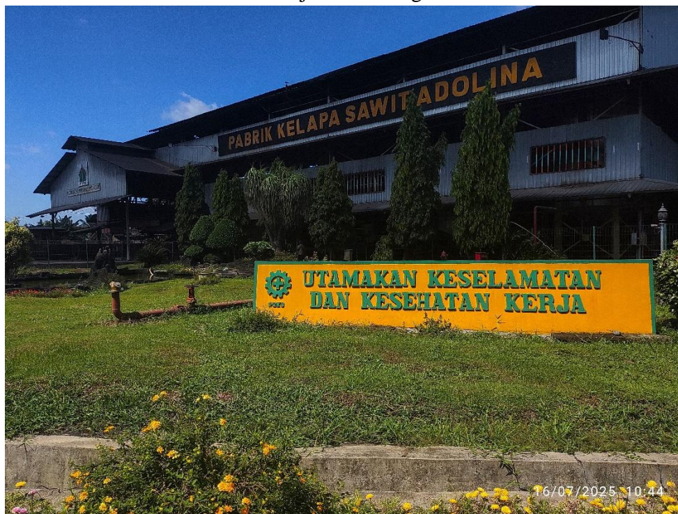
Gambar 2. 1 Pabrik Kelapa Sawit Adolina
