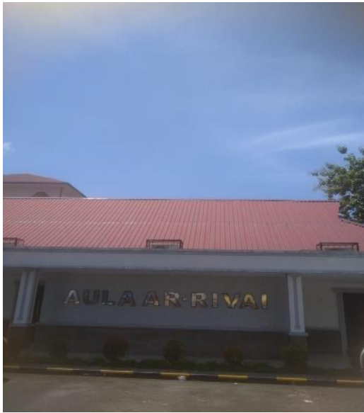
Gedung Aula MTs TPI
