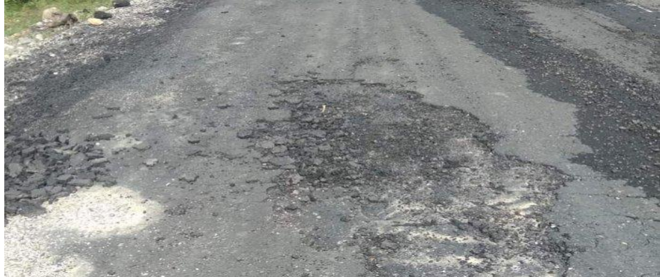
Gambar 39. Pengelupasan lapisan permukaan Sumber : Serambi, 2008
