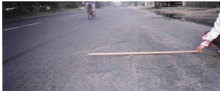
Gambar 30. Retak susut Sumber : Shahin, 2003
