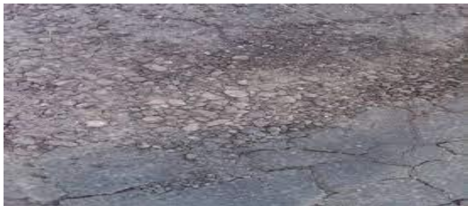
Gambar 38. Pelepasan butir Sumber : Shahin, 2003
