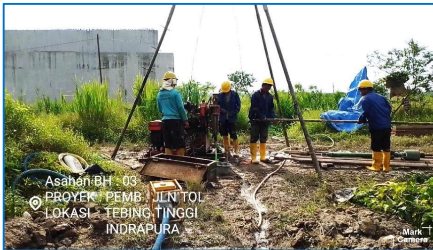
Pengujian Bor Mesin Titik - 3 (BH-3)
