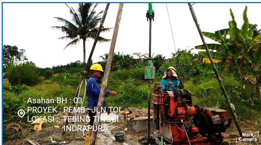
Pengujian Bor Mesin Titik - 3 (BH-3)
