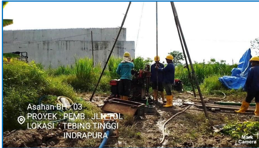
Pengujian Bor Mesin Titik - 3 (BH-3)
