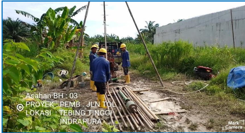
Pengujian Bor Mesin Titik - 3 (BH-3)
