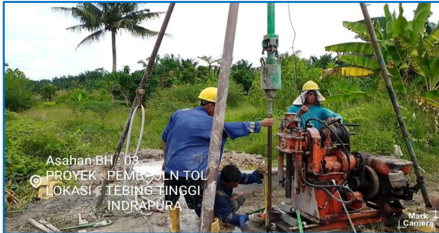
Pengujian Bor Mesin Titik - 3 (BH-3)
