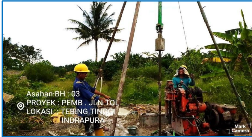
Pengujian Bor Mesin Titik - 3 (BH-3) Sta. 4 + 150
