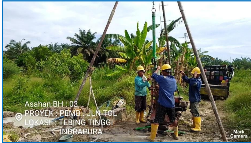
Pengujian Bor Mesin Titik - 3 (BH-3)
