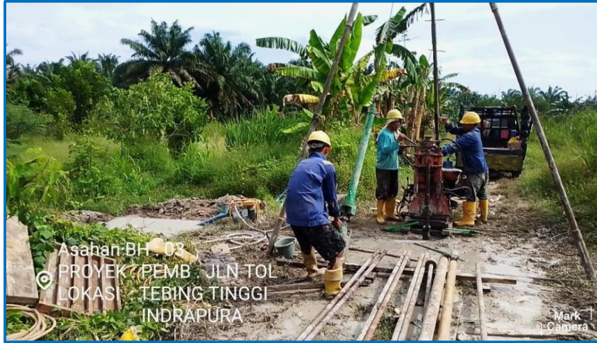
Pengujian Bor Mesin Titik - 3 (BH-3)
