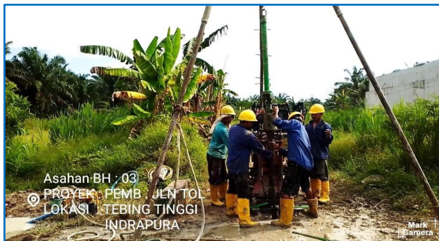
Pengujian Bor Mesin Titik - 3 (BH-3)
