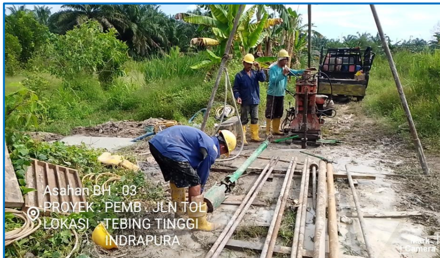
Pengujian Bor Mesin Titik - 3 (BH-3)
