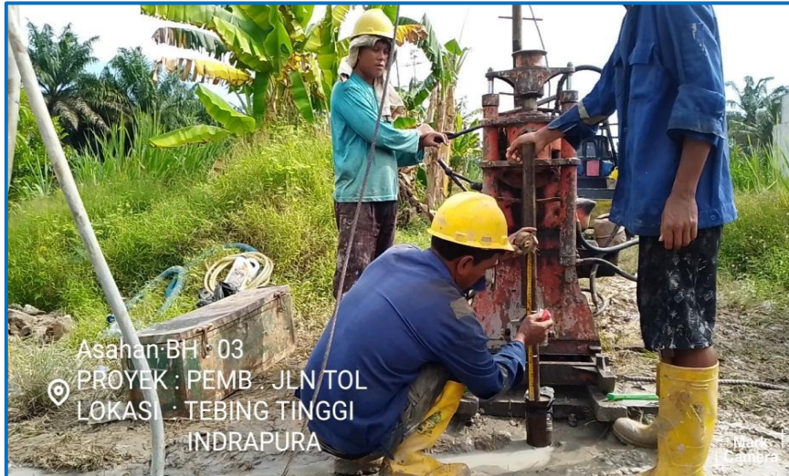
Pengujian Bor Mesin Titik - 3 (BH-3) Sta. 4 + 150
