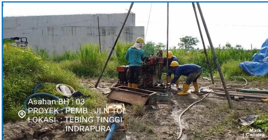
Pengujian Bor Mesin Titik - 3 (BH-3)
