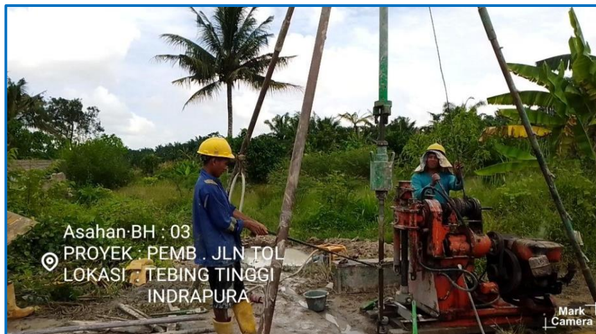
Pengujian Bor Mesin Titik - 3 (BH-3)
