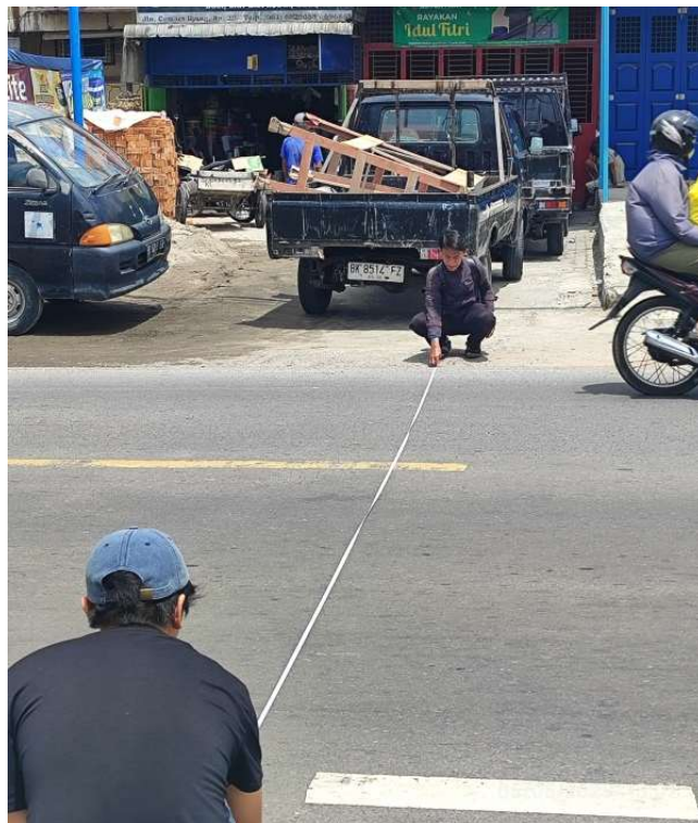
Gambar pengukuran geometrik jalan Cemara
