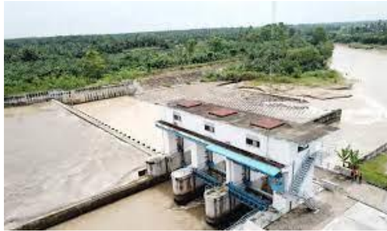
Gambar 2. 2 Bangunan Intake Sumber : Dinas Sumber Daya Air
