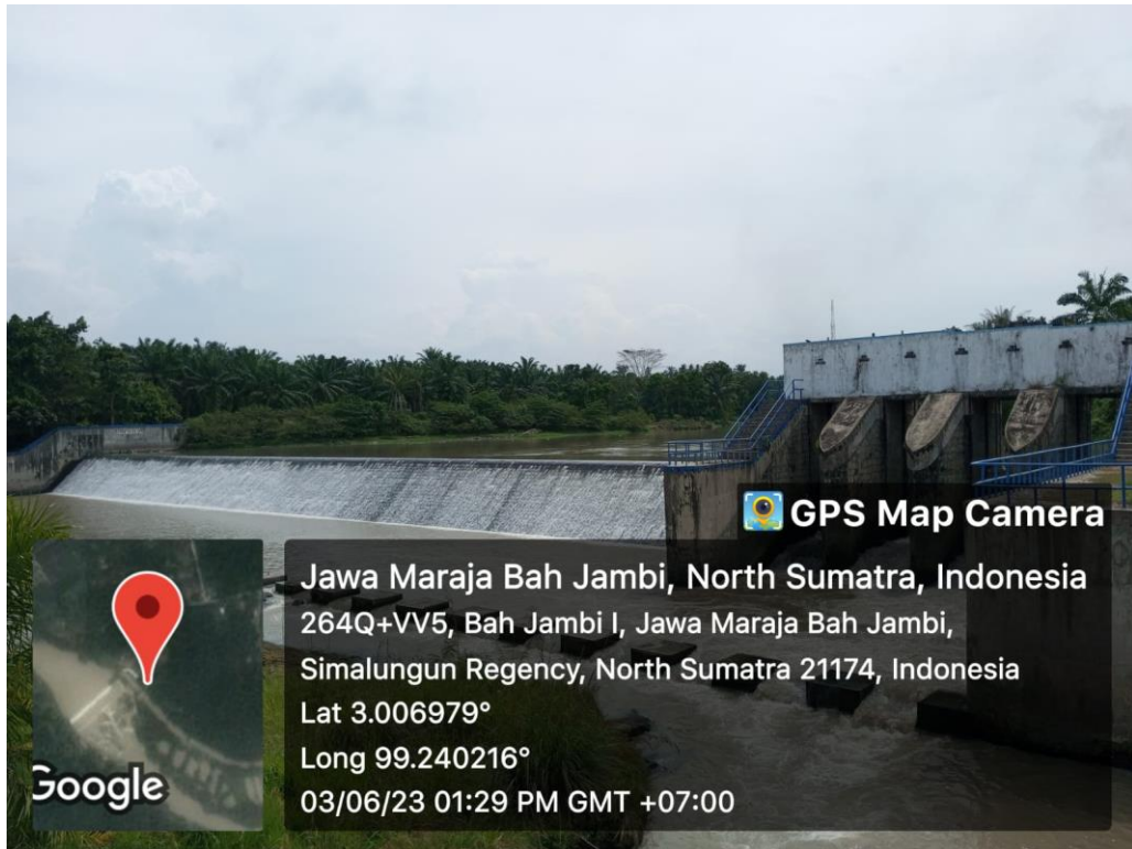
Dokumentasi 1. 1 Tampak Samping Bendung D.I Kerasaan
