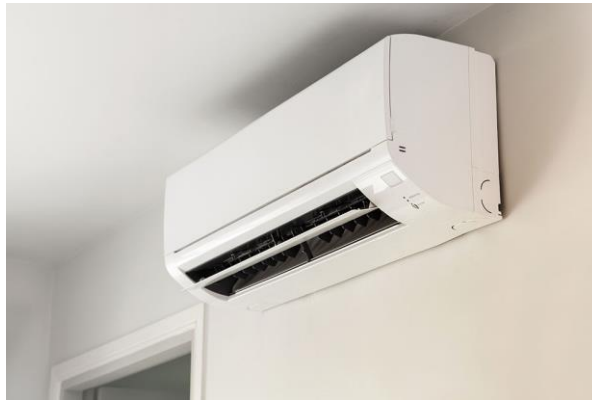
Gambar 2.15 Suatu Kemampuan Ac Dalam Mendinginkan Ruangan Dilihat Dari Nilai Pk AC Tersebut.
