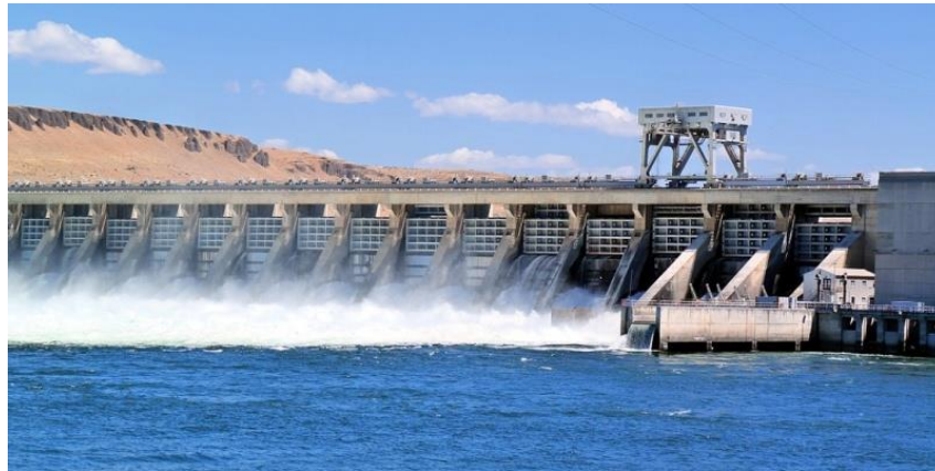
Gambar 2.1 Pembangkit Listrik Tenaga Air
