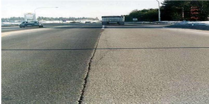
Gambar 2.6 Retak Sambungan Jalan (Shahin, 2005)
