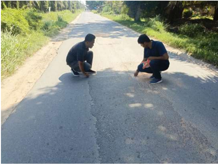
FOTO SURVEY LOKASI
