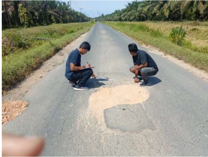
FOTO SURVEY LOKASI
