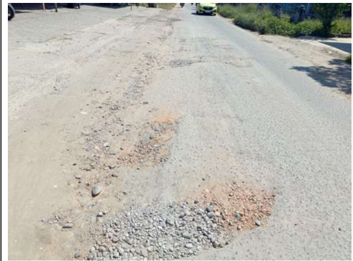
FOTO SURVEY LOKASI
