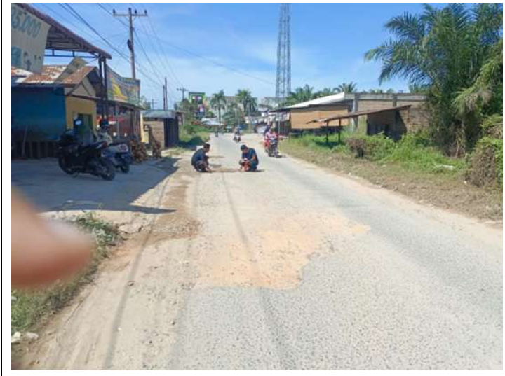
FOTO SURVEY LOKASI
