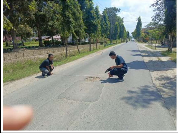
FOTO SURVEY LOKASI
