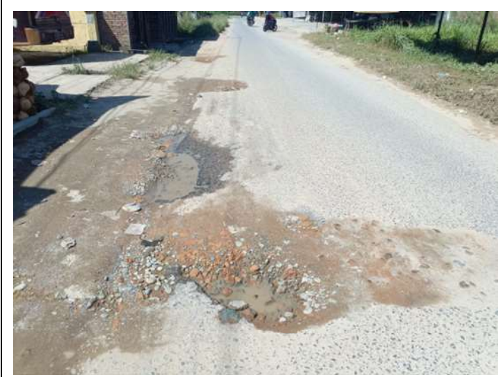
FOTO SURVEY LOKASI
