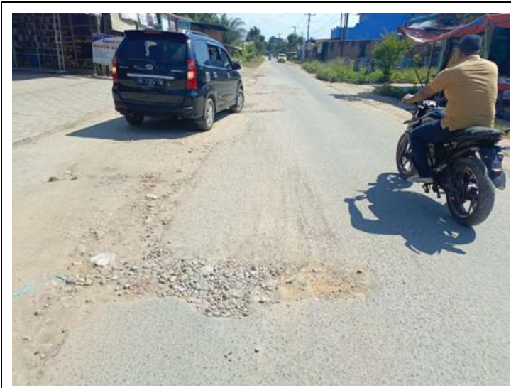
FOTO SURVEY LOKASI
