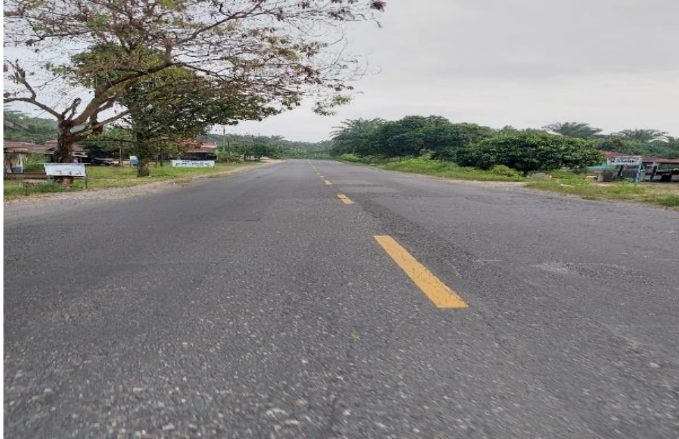
Keadaan lingkungan jalan di Desa Aek batu
