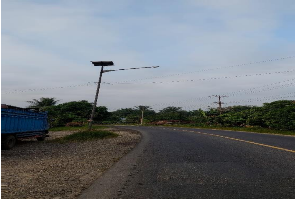
Fasilitas penereangan jalan di Desa Aek Batu
