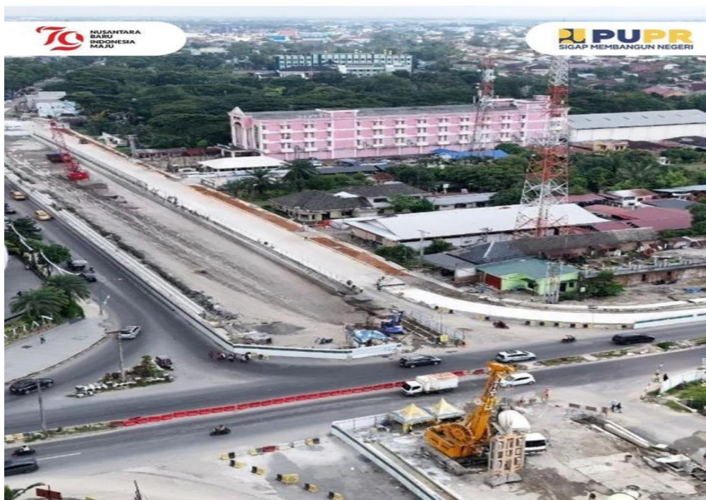
Gambar Saat Pembangunan Underpass Gatot Subroto
