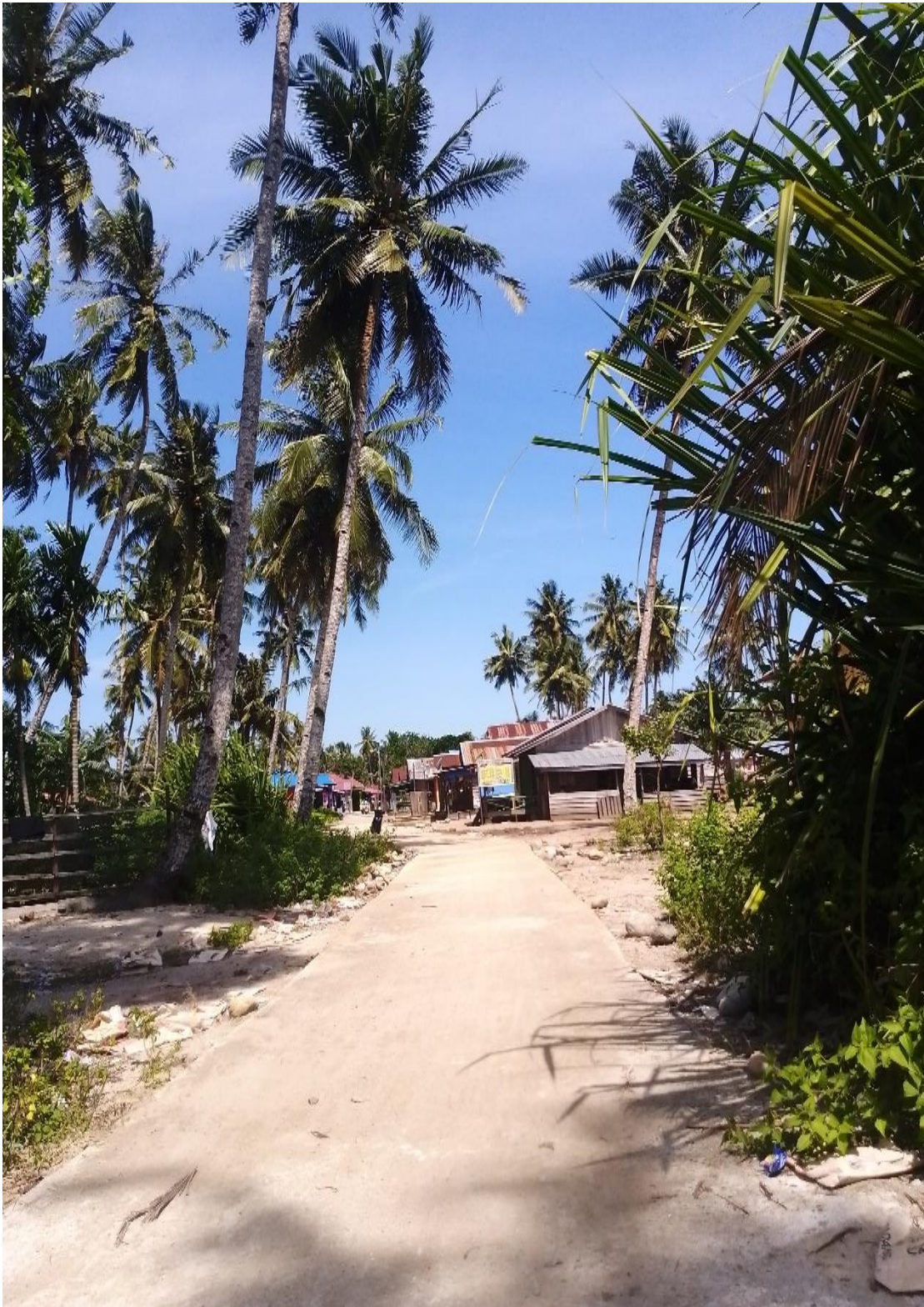
Gambar.3 Pembangunan jalan di Desa Singkuang II
