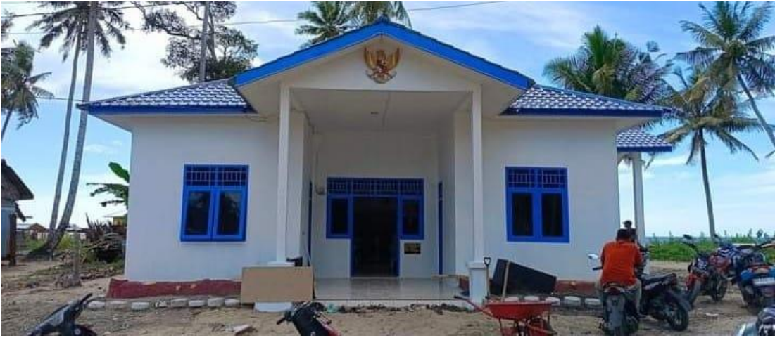
Gambar 1. Bangunan Gedung Serbaguna Desa Singkuang II
