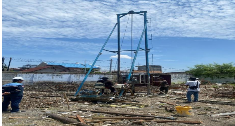
Gambar 2.7 Bored pile gawangan Sumber : Dokumen Pribadi (2023)
