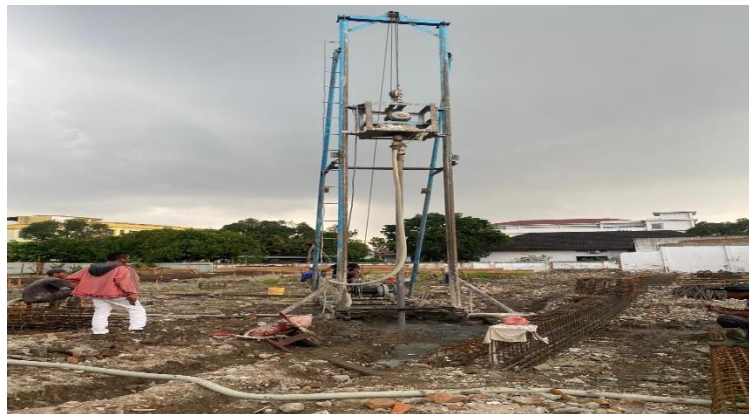
Gambar 2.6 Pembuatan bored pile mini crane Sumber : dokumen pribadi (2023)
