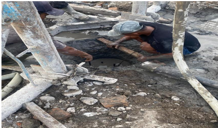
Gambar 2.8 Sistem Augering Sumber : Dokumen Pribadi (2023)
