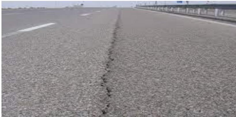
Gambar 2.4 : Retak Sambungan Bahu dan Perkerasan (*Edge Joint Cracks*)
