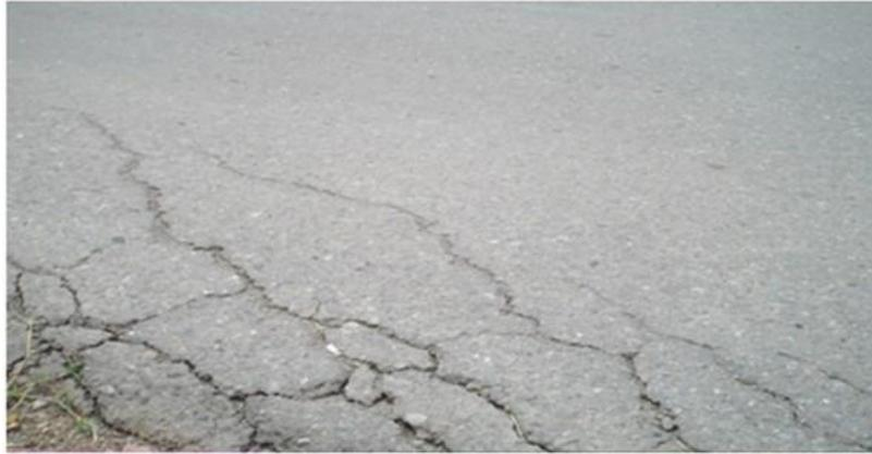
Gambar 2.2 : Retak kulit buaya (*Alligator Crack*)
