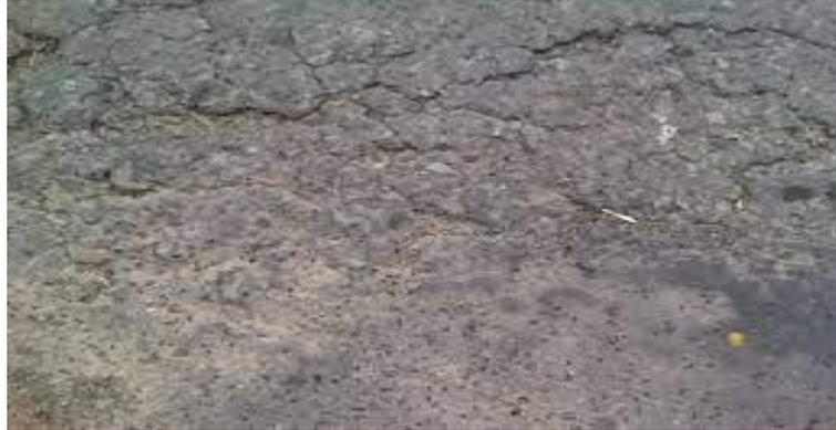
Gambar 2.12 : Pelepasan Butir (*Weathering/Raveling*)
