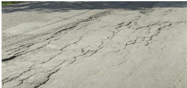
Gambar 2.14 : Penurunan pada bekas penambalan Untlitas (*Utility Cut Depression*)
