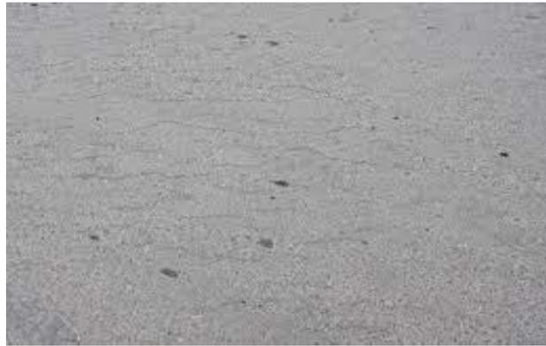
Gambar 2.1 Retak Rambut (*Hair Cracks*)
