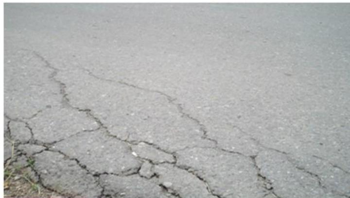
Gambar 2.3 : Retak Pinggir (*Edge Crack*)
