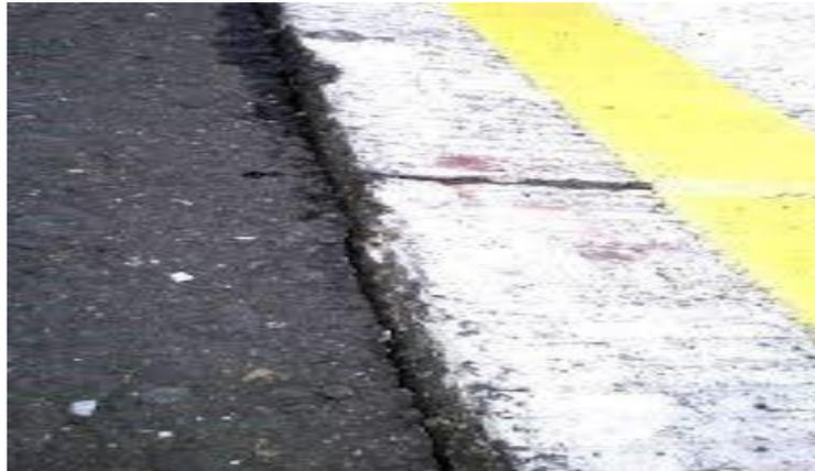
Gambar 2.5 : Retak Sambungan Jalan (*Lane Joint Cracks*)
