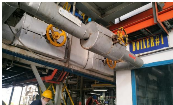
Gambar 2.25. Valve pemasukan air
