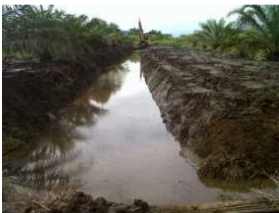
Gambar 9. Pembuatan Parit Irigasi (Sistem Water Manajemen )
