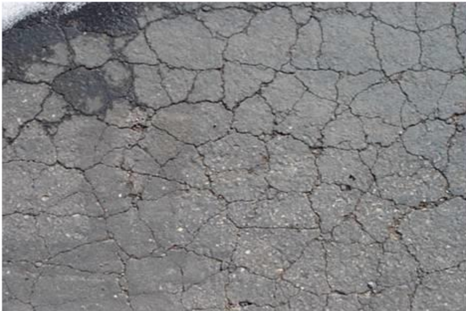
Gambar 2.9 Retak Susut
