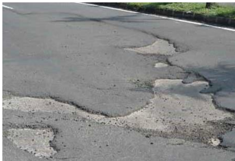
Gambar 2.18 Pengelupasan Lapisan Permukaan
