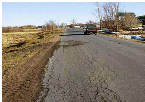
Gambar 2.5 Retak pinggir
