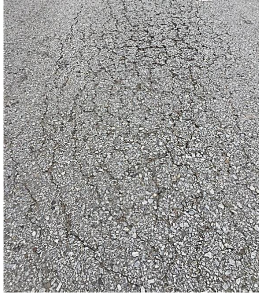
Gambar 2.1 Contoh kerusakan Retak Kulit Buaya ( Alligator Cracking ) (Sumber : Jln. Eka Sama, Gedung Johor, Medan Johor/2022)
