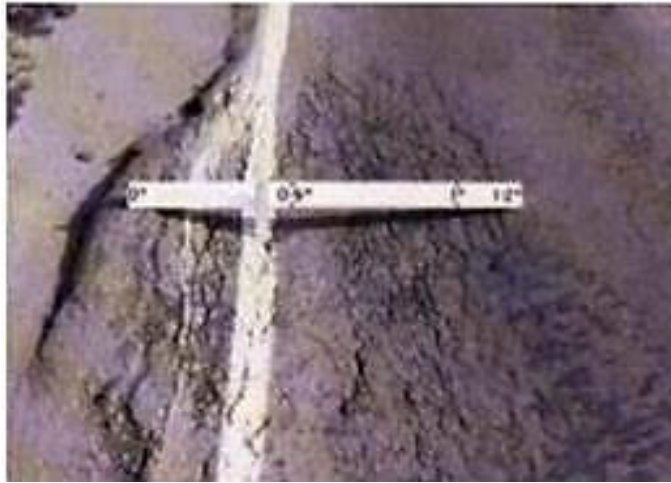
Gambar 2.14 Contoh Kerusakan Sungkur ( Shoving ) (Sumber : Bina Marga no.03/MN/B/1983)
