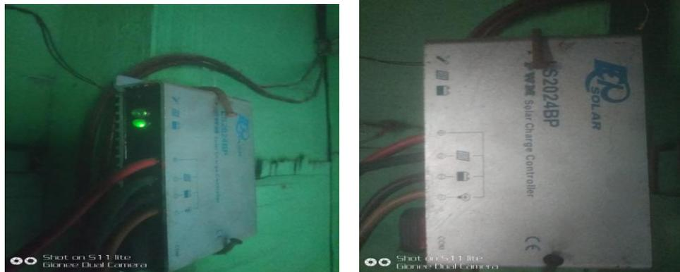
Gambar 2.17 Charge Controller Yang Sudah Terpasang Di Rumah
