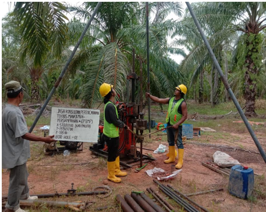
Gambar Dokumentasi Dilapangan
