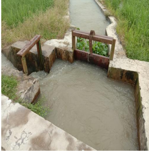
Bangunan Bagi sadap
