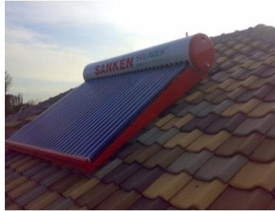
Gambar 2.4 Pemanas Air Tenaga Surya
