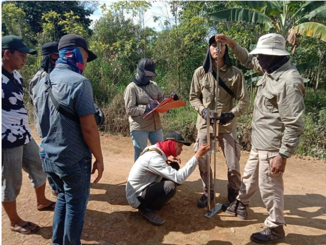
Penentuan Tebal Perkerasan Jalan, Dalam Proses Pembongkaran Ulang Konstruksi Jalan
