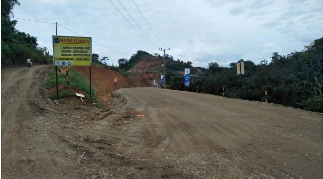
**Gambar A.1 Jalan relokasi sebelum dilakukan pemadatan**
