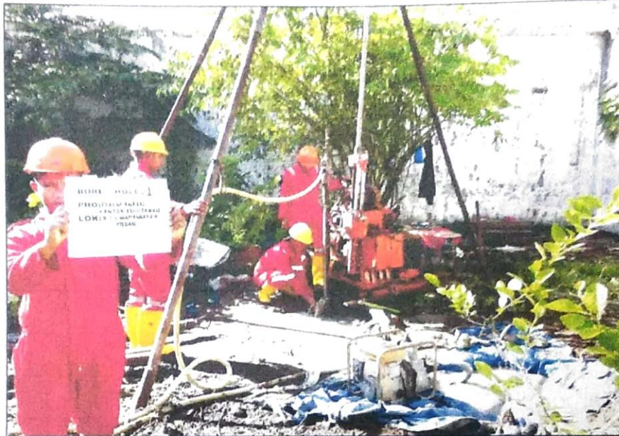
Pengujian Bor Mesin Titik - 1 (BH-1)
