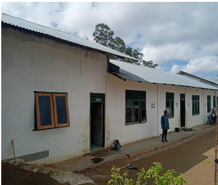
Gambar Dokumentasi Ruang Kelas Madrasah Aliyah Zakiyun Najah
