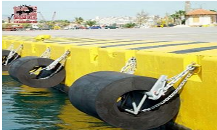
Gambar 2.22 Fender tipe silinder (Sumber : Nanjing Deers Industrial Co., Ltd)
