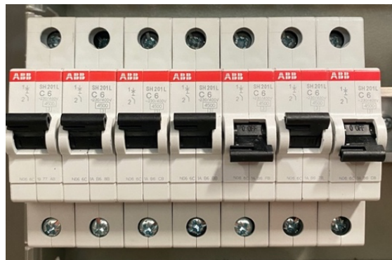
Gambar 2.6. Mini Cicrcuit Breaker (MCB)
