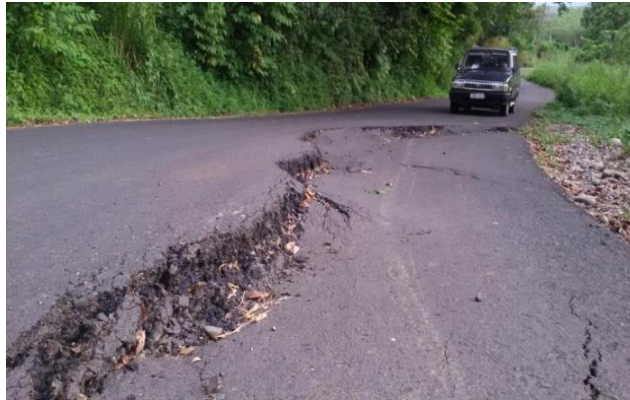
Gambar 2.14 Amblas Sumber: Sastroj Bangun
