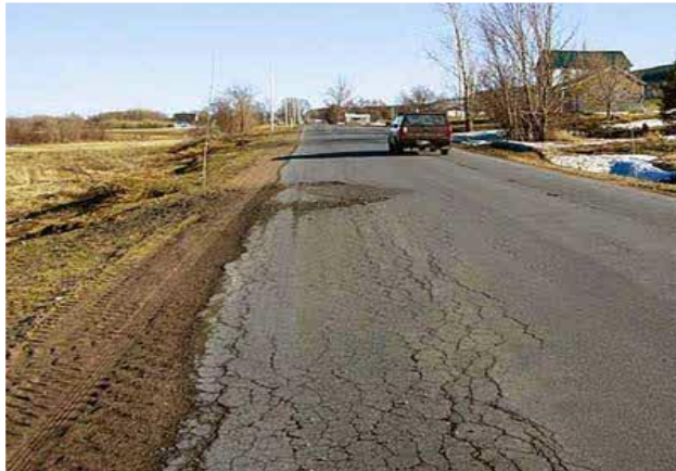
Gambar 2.5 Retak pinggir
