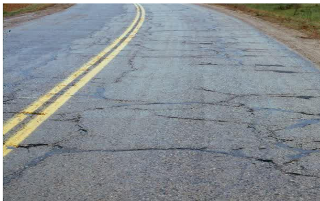
Gambar 2.8 Retak Refleksi
