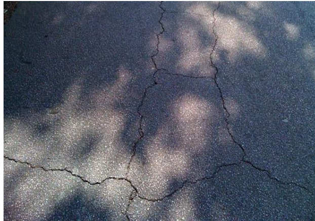
Gambar 2.3 Retak Halus
