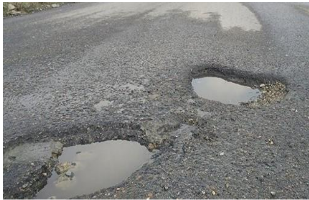
Gambar 2.16 Lubang Sumber: Survei lapangan
