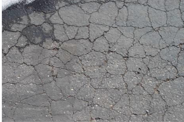
Gambar 2.9 Retak Susut
