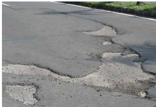
Gambar 2.18 Pengelupasan Lapisan Permukaan Sumber: Wiwin Anastasia
