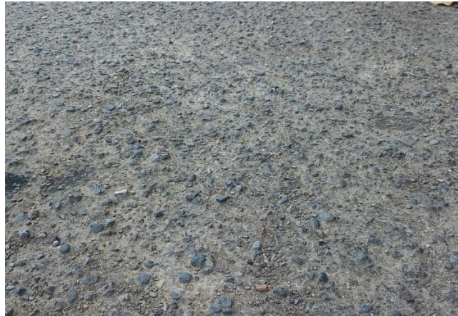
Gambar 2.17 Pelepasan Butir Sumber: Survei dilapangan
