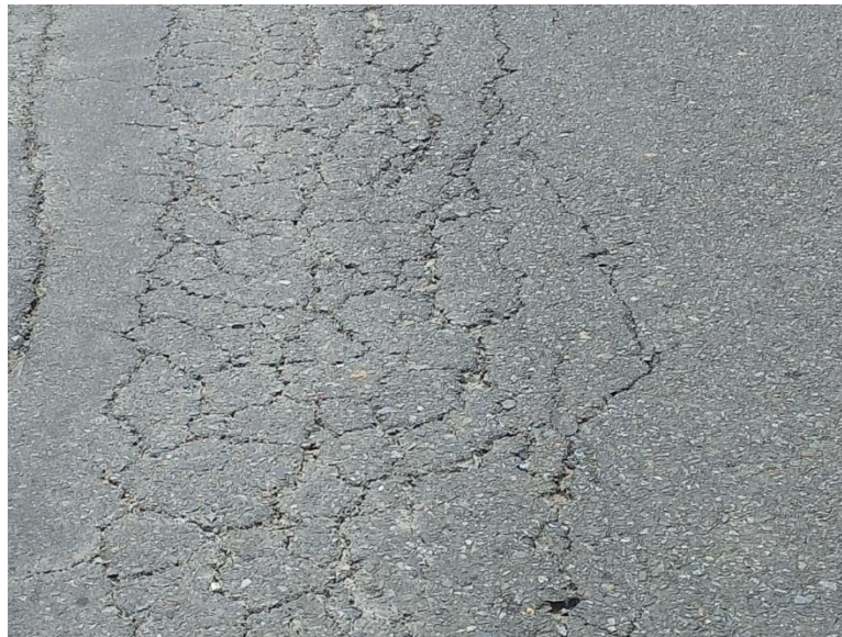
Gambar 4 Lampiran 1: Retak Kulit Buaya
