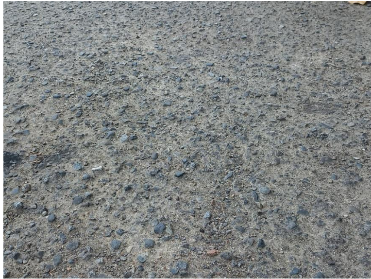
Gambar 5 Lampiran 1: Pelepasan Butir
