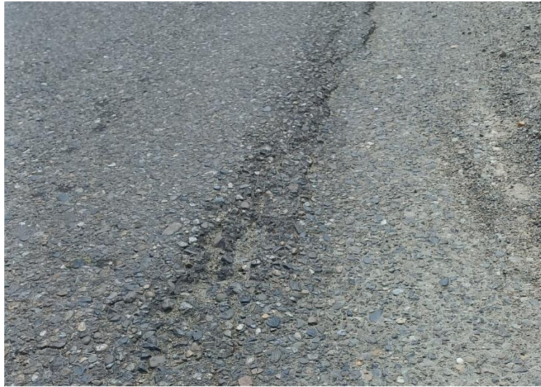
Gambar 3 Lampiran 1: Retak Memanjang
