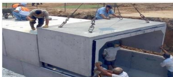
Gambar 2.18. Box Culvert memiliki spigot dan socket
