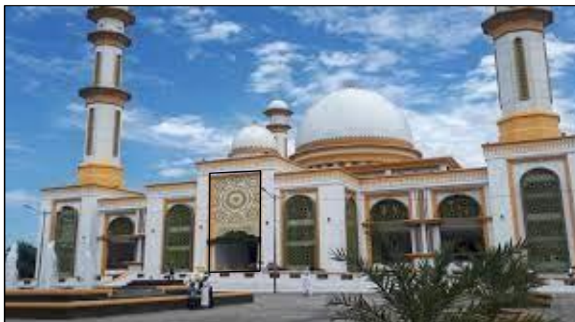
Gambar 2.6. Bagian Luar Bangunan Berbentuk Balok
